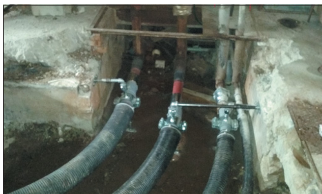
▼ Obr. 8 ● Fixace konců plastového potrubí systémovými úchyty do stěn kanálu
