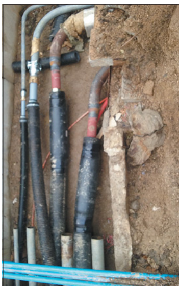
▲ Obr. 7 ● Izolace varných přechodů z ocelového potrubí na PB (polybutenové potrubí); odhalené části stávajícího potrubí byly zaizolovány po zprovoznění přípojky
