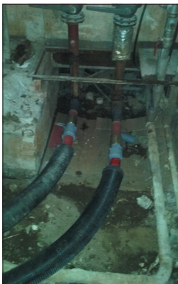
▲ Obr. 5 ● Po zhotovení přechodů ocel/PB v kanále i v domě (na obrázku) na ně bylo elektrickými svařovacími tvarovkami napojeno předizolované potrubí
